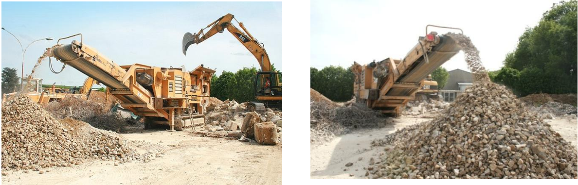
Figure II.6 : Concassage mobile, valorisation déchets inertes
