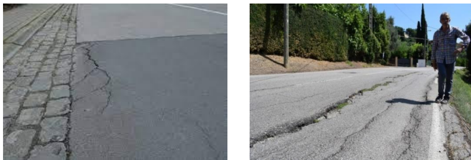
Figure I.15:Affaissement de rive.
