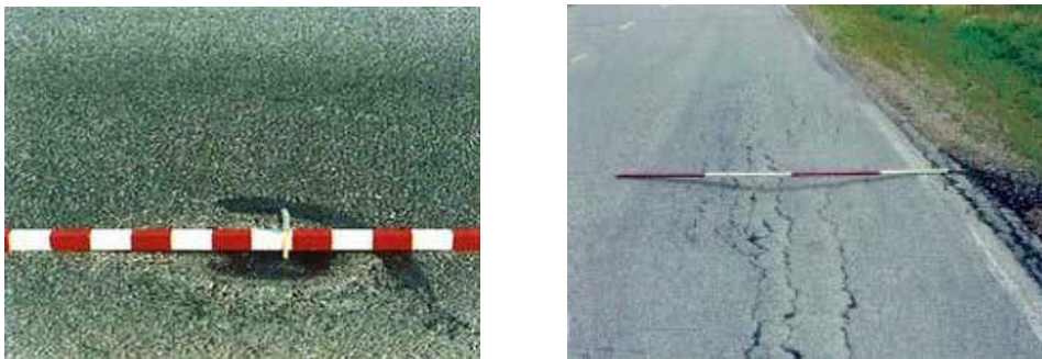
Figure I.17: Flashe L'affaissement hors rive (flashe) (LCPC, 1998)
