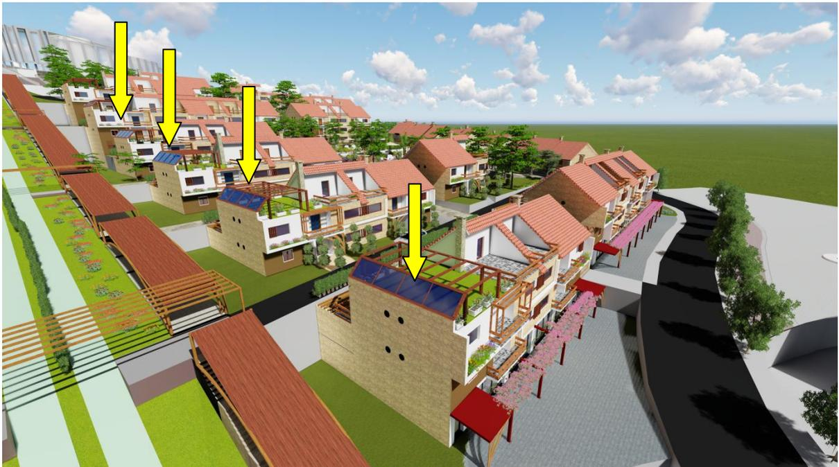
**Figure 109:** positionnement des capteurs plan vers la façade Sud
