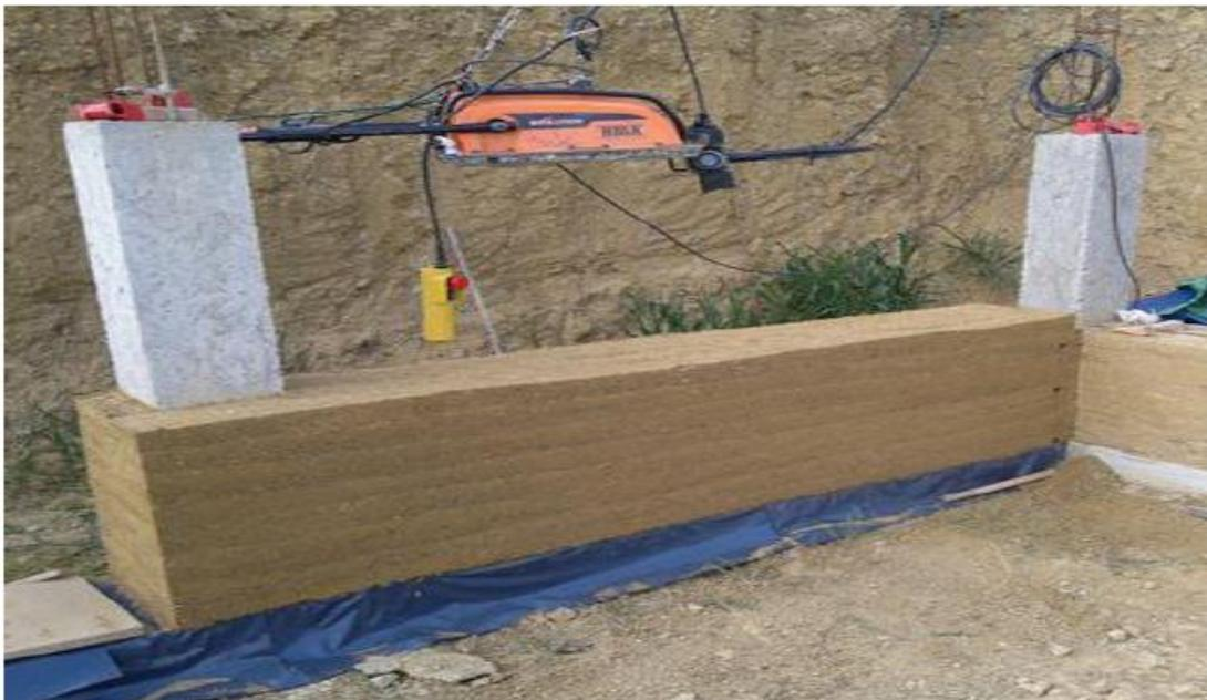
**Figure 102:** Chainage d'un mur en pisé avec une structure en BA
