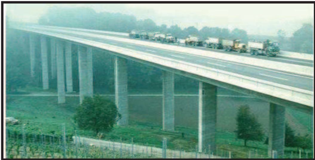
Figure II-3: pont à poutres multiples en béton précontraint.
