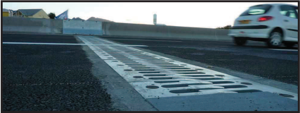
Figure XI.2 : Photo réelle d'un joint de chaussée
