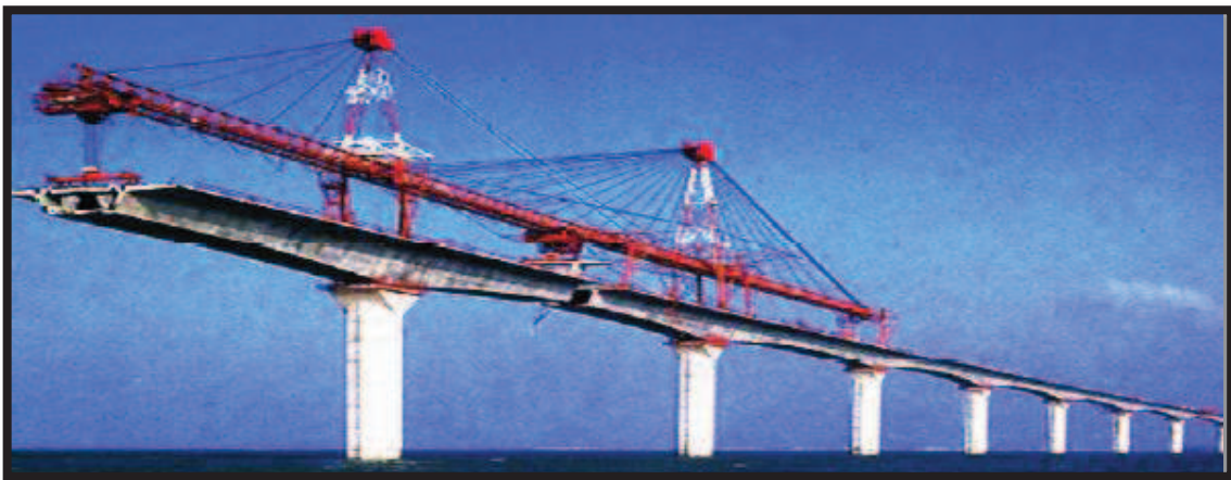
Figure II-4 : Ponts à caissons.
