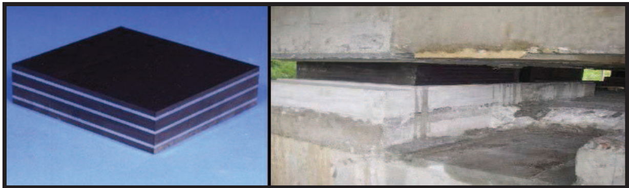
Figure XI.6 : Appareil d'appui en élastomère fretté.
