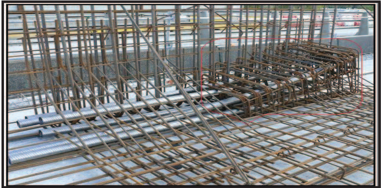
Figure IX.20: ferrailage d'un bossage dans un voussoir
