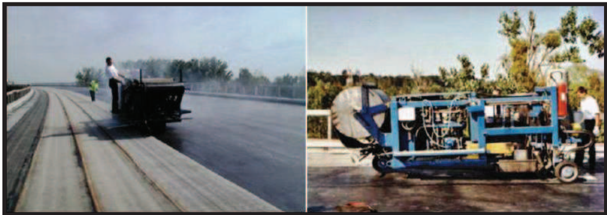
Figure X.11: Revêtement du tablier.
