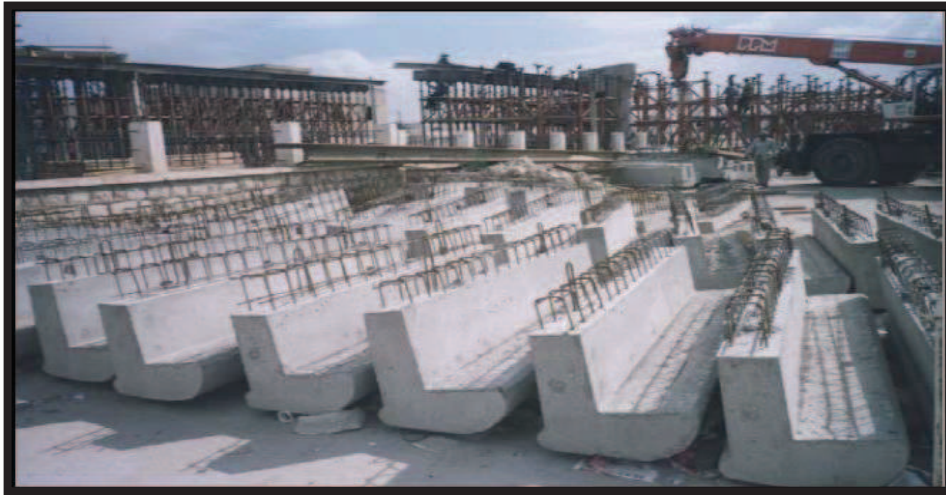
Figure XI.13 : Corniches préfabriquées sur chantier.
