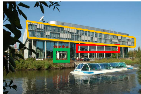
Figure 86: vue sur l'ensemble du bâtiment Source : http://www.arte.tv/sites/corporate/qui-sommes-nous-cluster/
