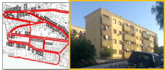
Figure 40: La cité 760 logements (Dahlia) ; Source : Auteurs
