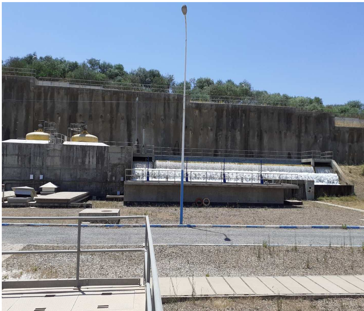
Figure.2.2. Les deux brises charge de la station Koudiet Acerdoune.
