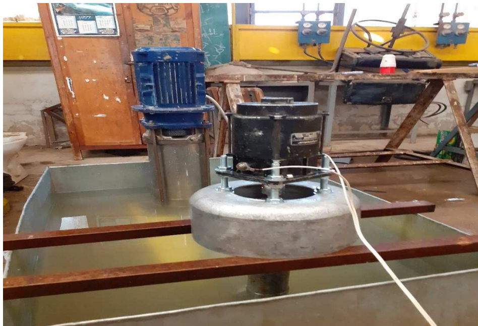
Figure.4.19. Installation de la génératrice.
