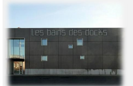
Figure 87: Façades des docks de havre.
