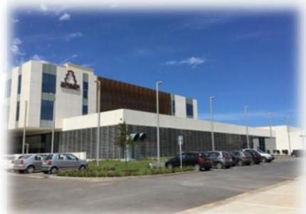
Figure 102: Vue sur l'école.
