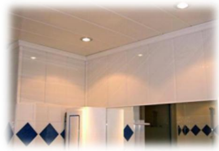
Figure 175: faux plafond en pvc.
