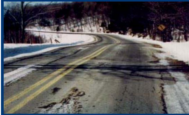
Figure I.17. Soulèvement différentiel (MTQ, 2002)
