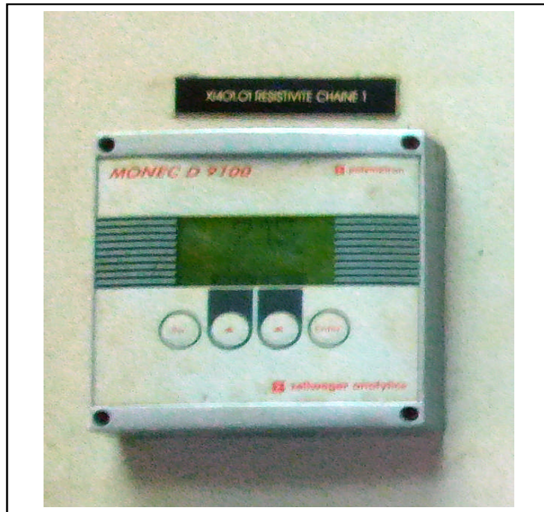
Figure 31 : Afficheur de résistivité
