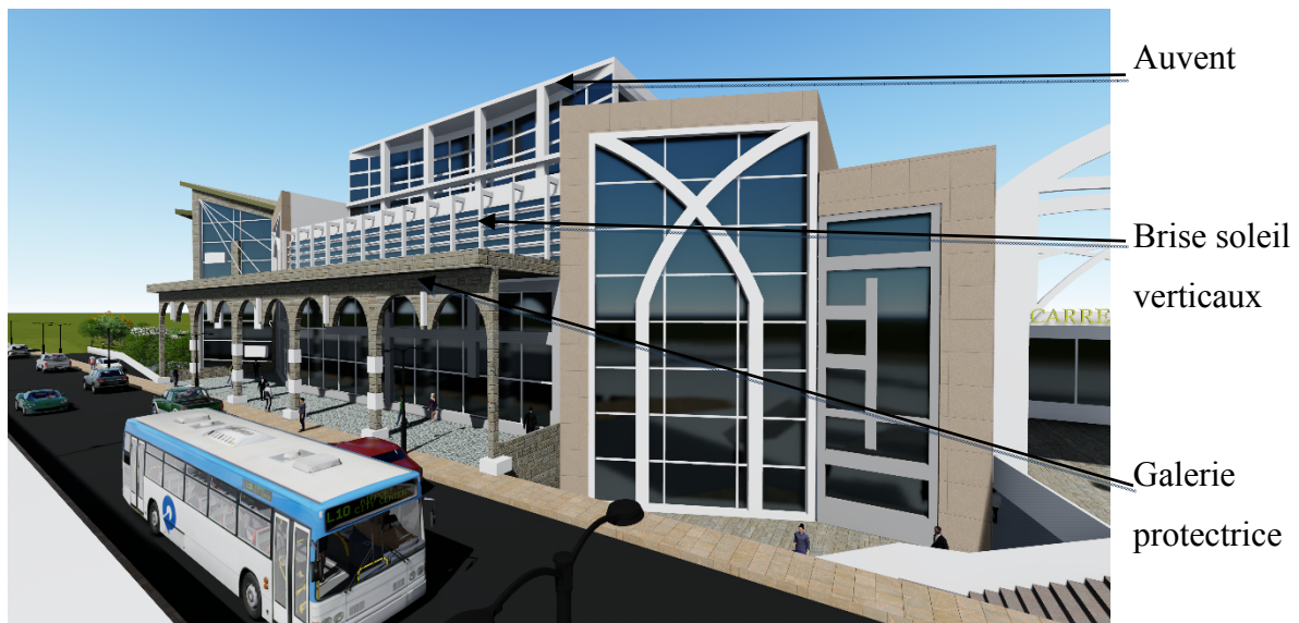
Figure 13 : vue sur les brises soleil du côté ouest.
