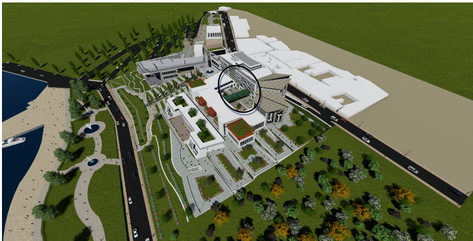
Figure 7 : vu sur le patio de l'école.
