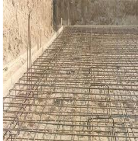
Figure 3 : vue sur un radier général
