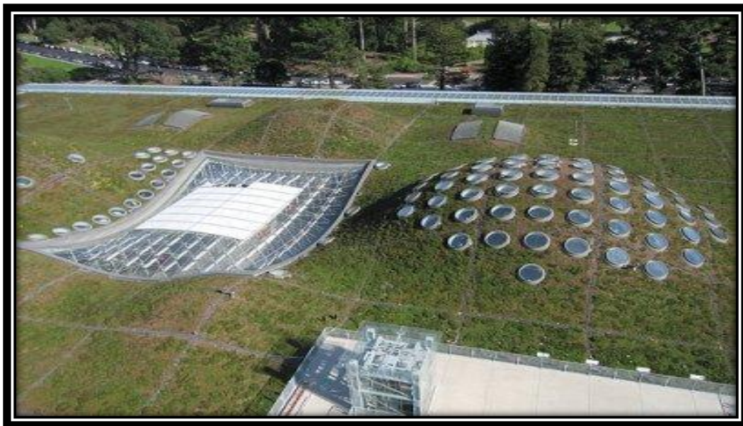
Figure 57: Toit vert avec panneaux solaires
