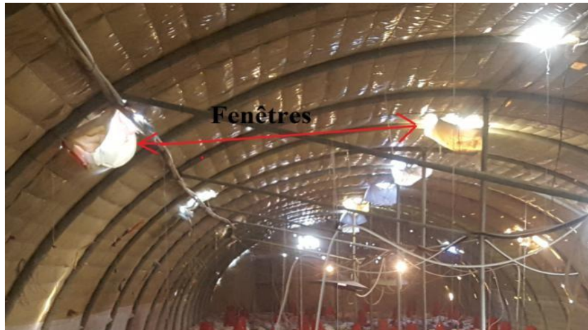
Figure 15: Exemple d'une ventilation statique
