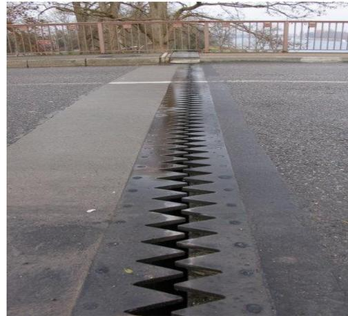
*Fig. (X.9): Joint du type Wd110 (souffle moyen).*
