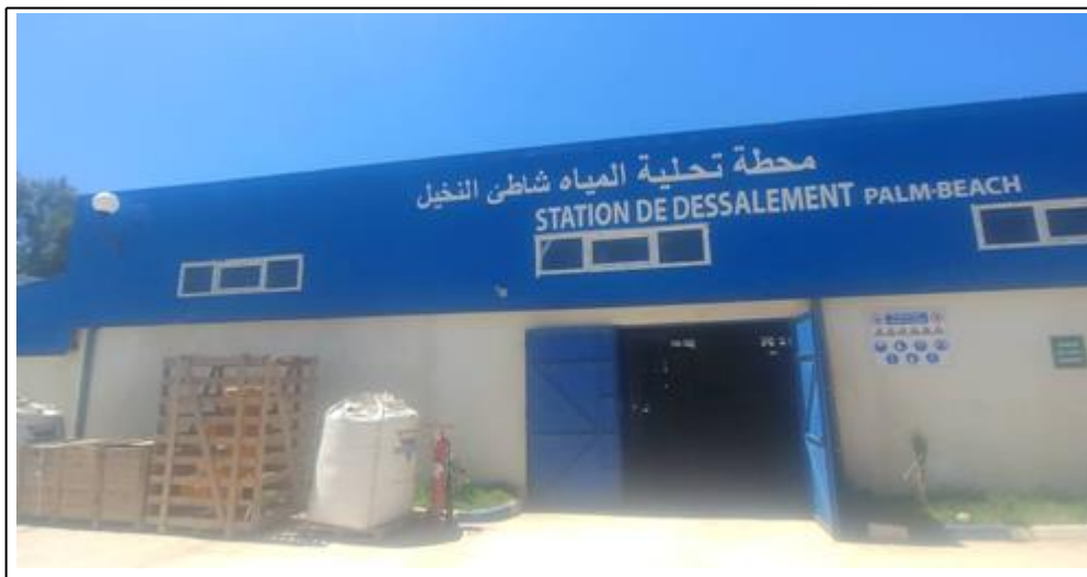
Figure IV.1 : Photo représentative de l'usine de dessalement de Palm Beach
