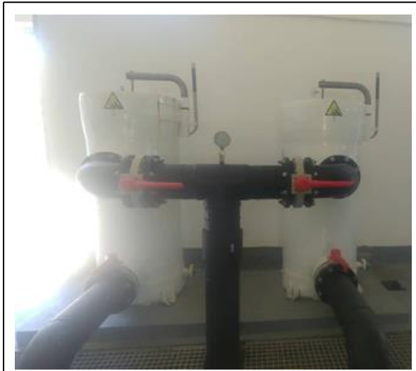
Figure IV.7: Réservoir de micro filtres
