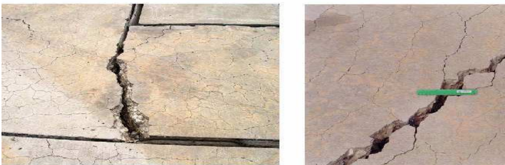
Figure 2.1 :fissurations grossières dues à l'alcali – réaction (Entrée d'un tunnel) [26].
