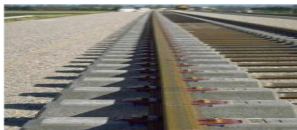
Figure VII-10 : Travers en Bi bloc
