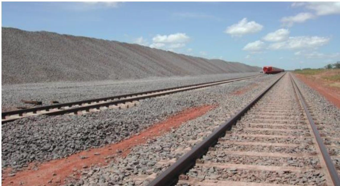
Fig I-1: Les infrastructures de transport ferroviaire
