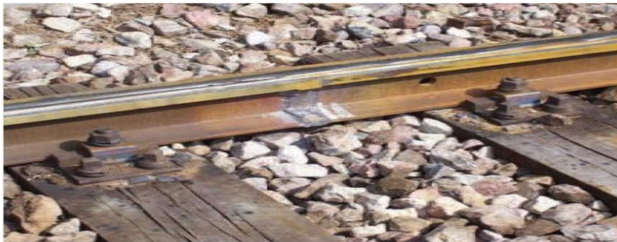
Figure VII-8 : photo d'une barre soudée
