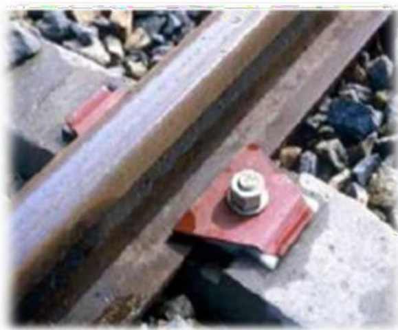
Figure VII- 15 : attache de type Nabla
