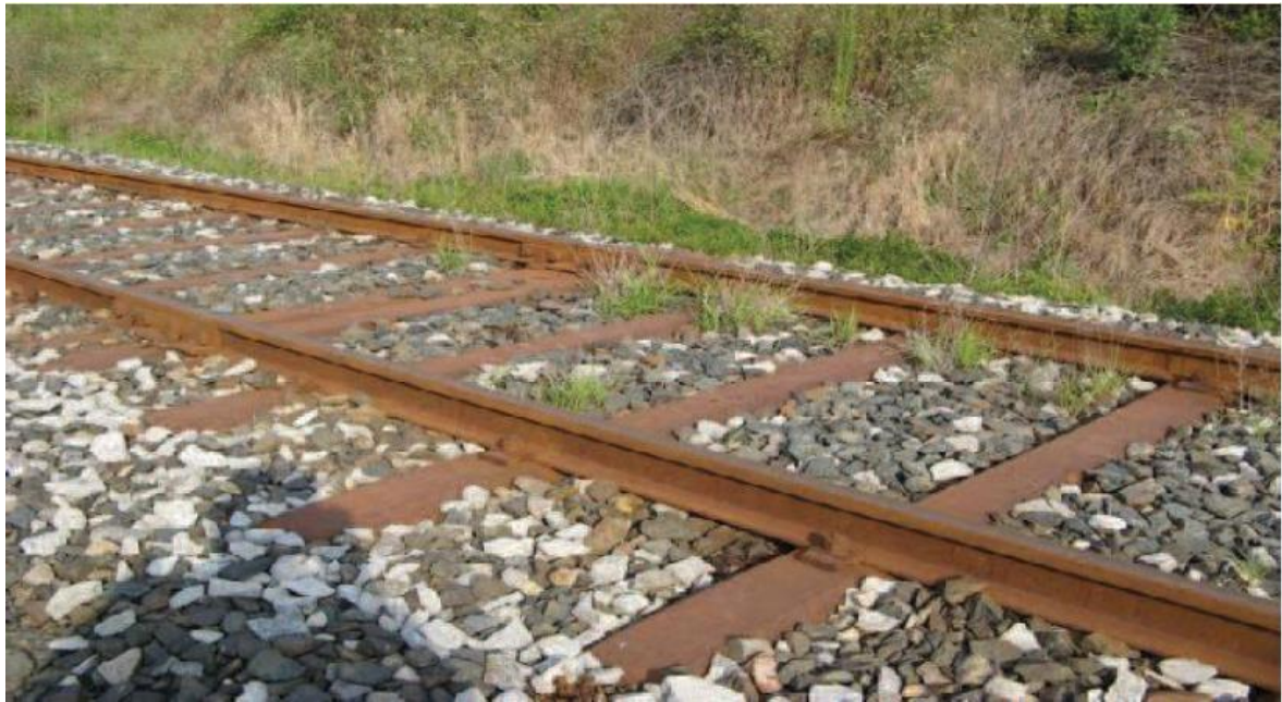
Figure VII-14 : Travers métalliques
