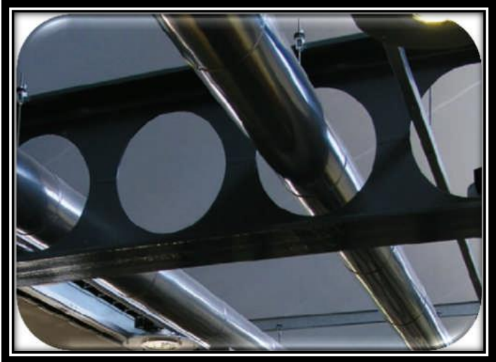
Figure n° 79 : Poutres alvéolaires
