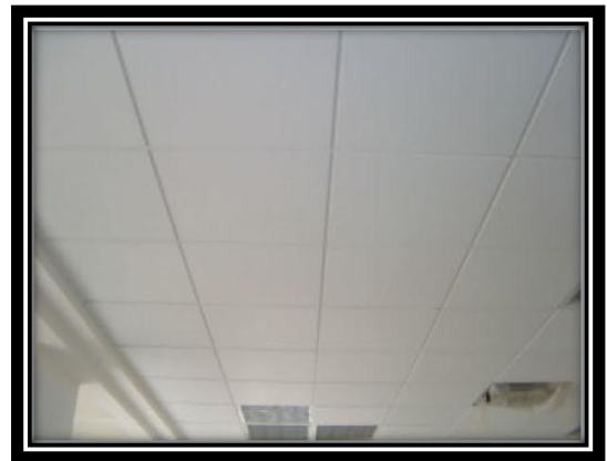
Figure n° 91 : Exemple de faux plafond
