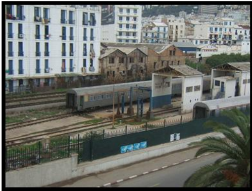
Figure 26 : La gare Agha
