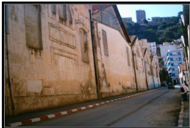
Figure 44 : vue sur la rue.
