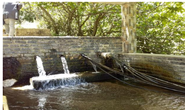
Fig.24 - Phénomène de captage des eaux à Ait-Boumahdi
