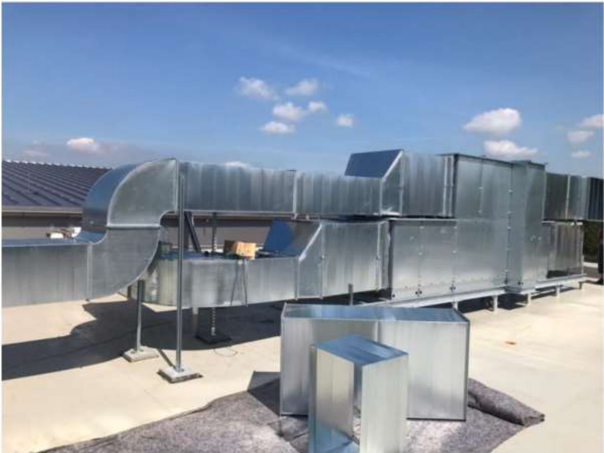
Figure III.8 : Exemple d'une gaine de réseaux aéraulique rectangulaire.
