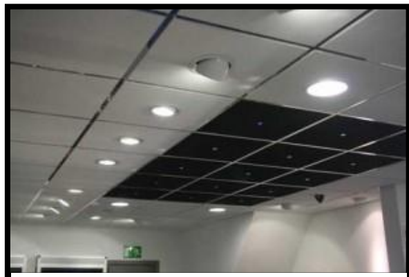
Figure 74 : un faux plafond en PVC www.hellopro.fr
