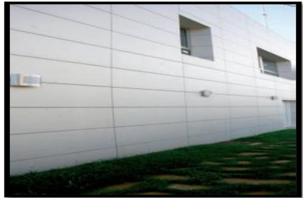
Figure 62 : Façade ventilées en béton fin. http://www.construire-tendance.com
