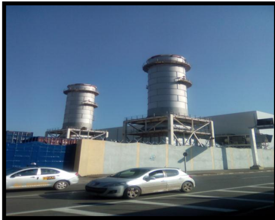
Figure 42 : central électrique Source : les auteures
