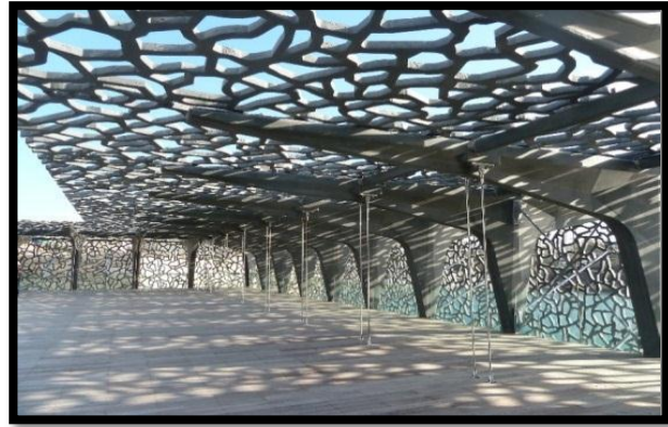
Figure 66 : couverture perforée en béton résille
