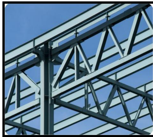
Figure 56 ; schéma présentatif d'un assemblage poteau-poutre métallique
