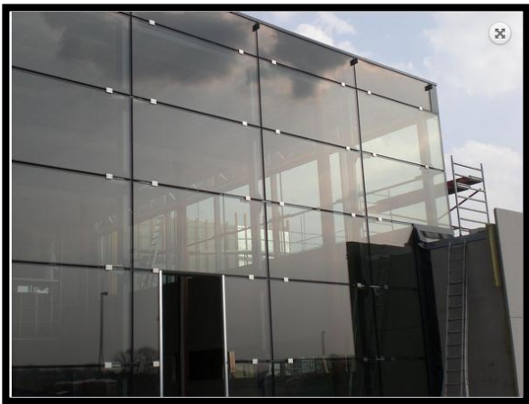
Figure 60 : image d'une façade avec mur rideau
