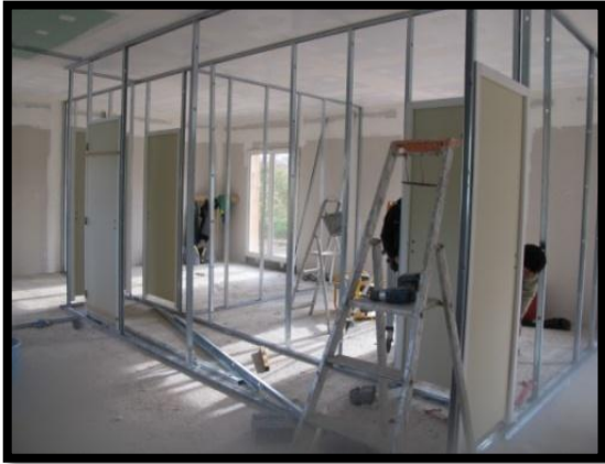
Figure 70: système de fixation des cloisons Http // :www. Over-blog.com
