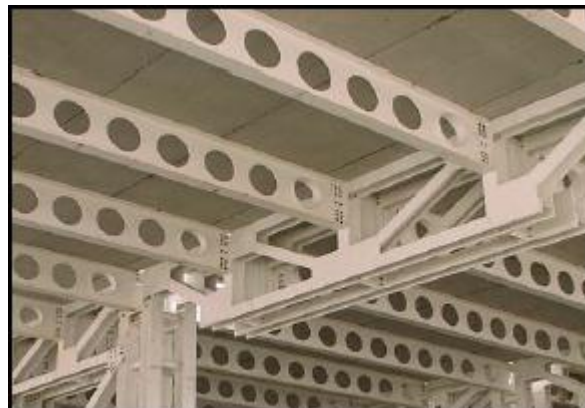
Figure 52 : photo d'une poutre alvéolaire.
