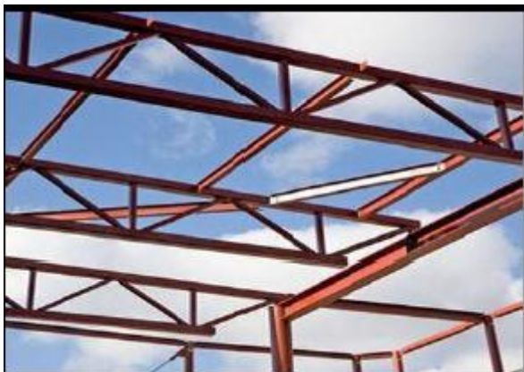
Figure 53 : photo d'une poutre treillis.
