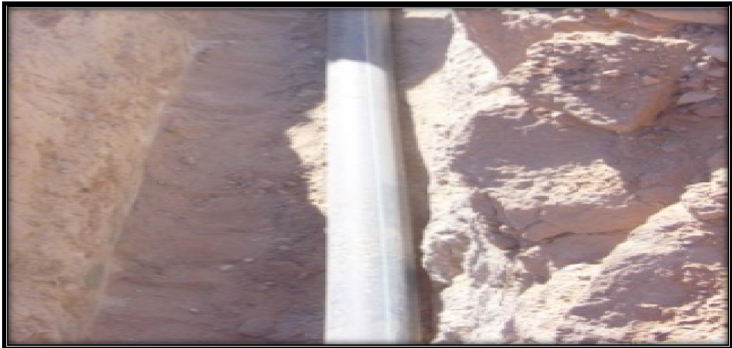
Figure 5.1 : pose des conduites en terre
