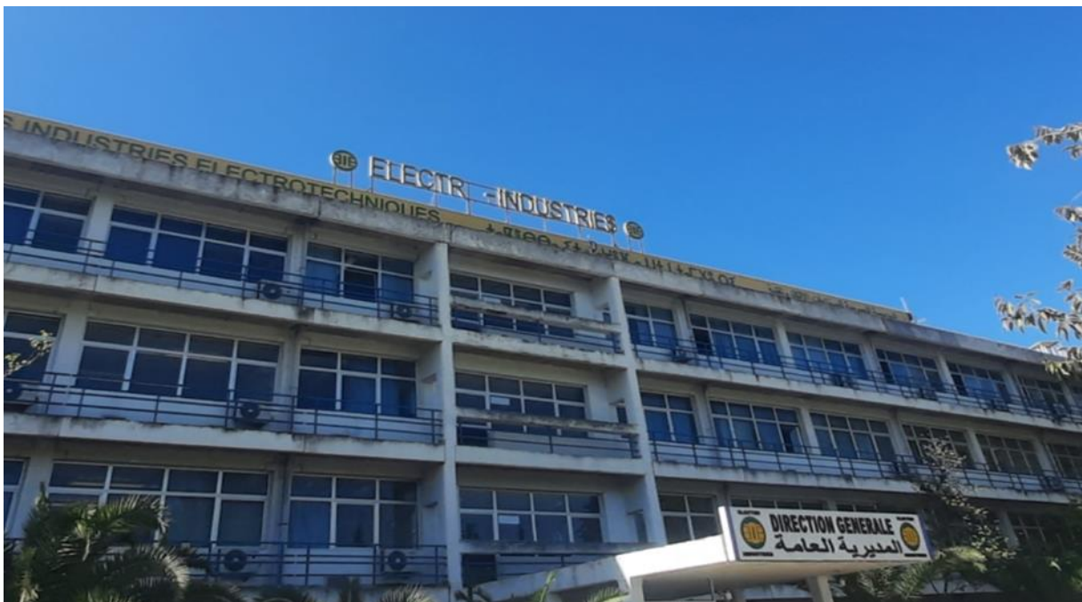
Figure 2 : Complexe Electro-Industries d'AZAZGA (Originelle, 2022).
