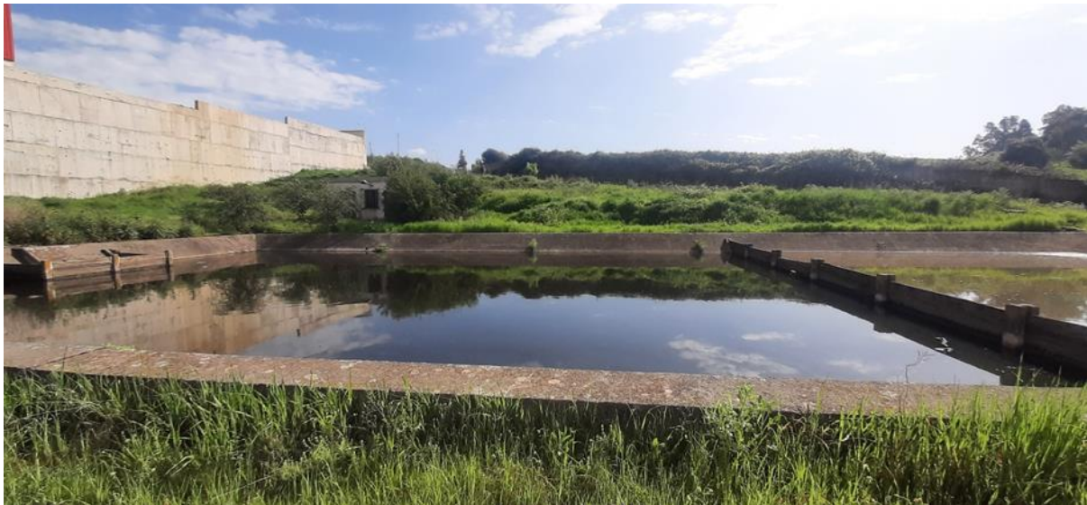
Figure 7 : Les bassins de décantation de la station d'épuration de l'EI (Originelle, 2022).
