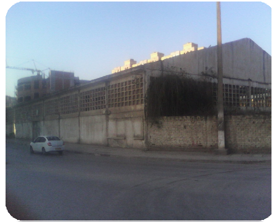
Figure : ancienne briqueterie de mézzaia Source : auteurs
