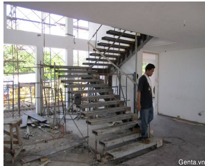
Montage de la structure du garde corps
