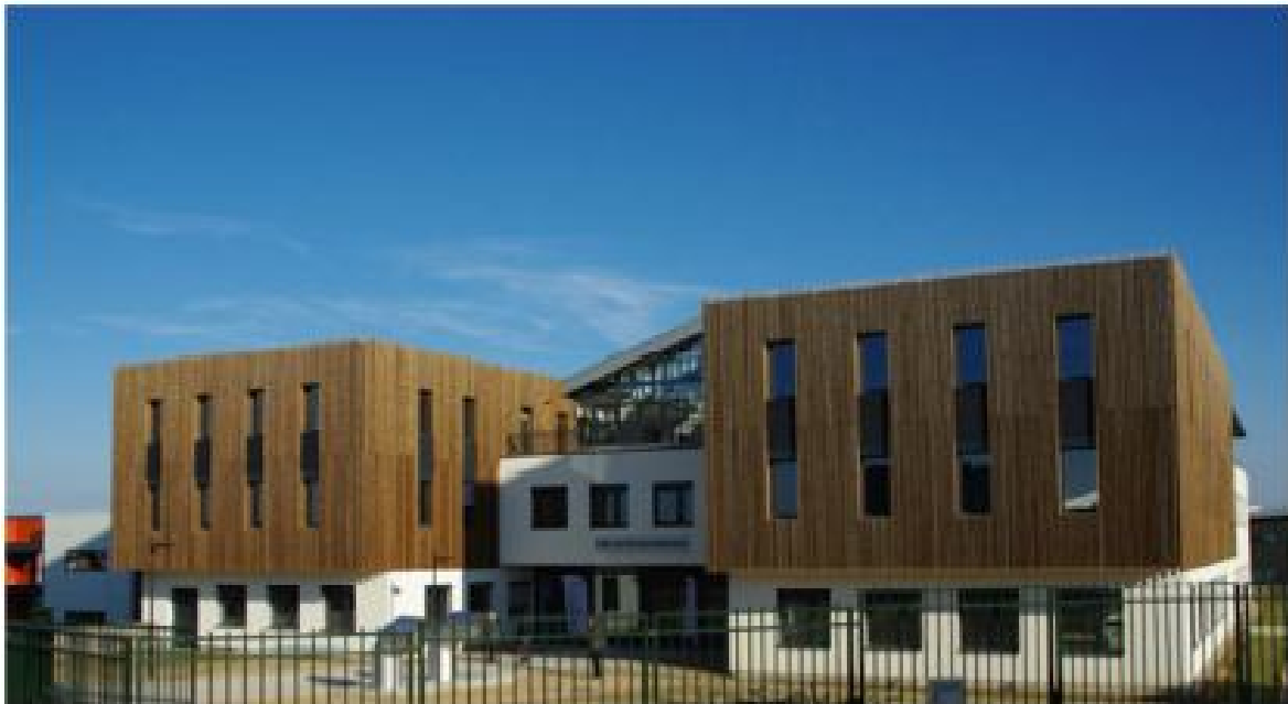
Photo : enveloppe du bâtiment Source : http://www.googleimg/cité de l'environnement
