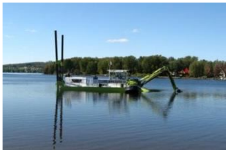
Travaux de dragage
