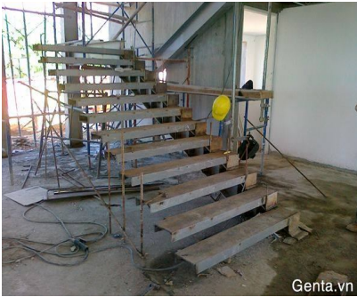
Première étape de montage des limons Et supports des marches.
