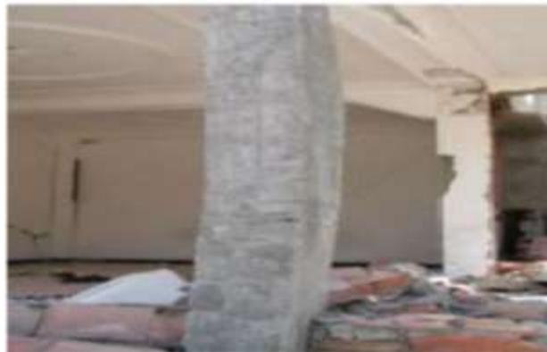
Figure II.A.12 : Flambement d'un poteau [AFPS, 2003]
