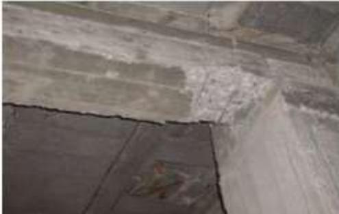
Figure II.A.9a : Rotule dans la poutre (comportement recherché)
