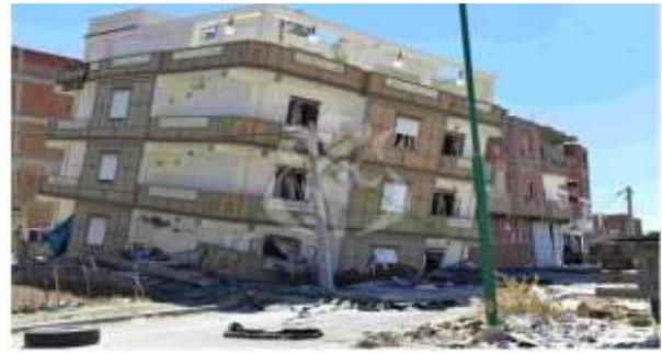
Fig. II.A.7b : Basculement d'une habitation après le séisme de Mila en 2020 [CRAAG, 2020]
