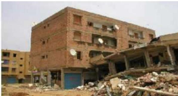
Fig. II.A.7a : Effondrement d'une habitation après le séisme de Boumerdès en 2003 [AFPS, 2003]
