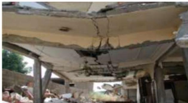
Figure II.A.13 : Rupture par flexion des poutres [AFPS, 2003]
