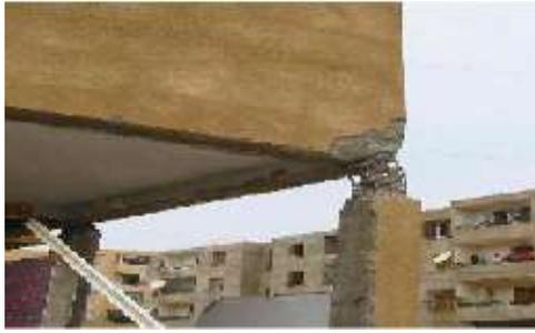
Figure II.A.8a: Rupture en zone nodale [AFPS, 2003]
