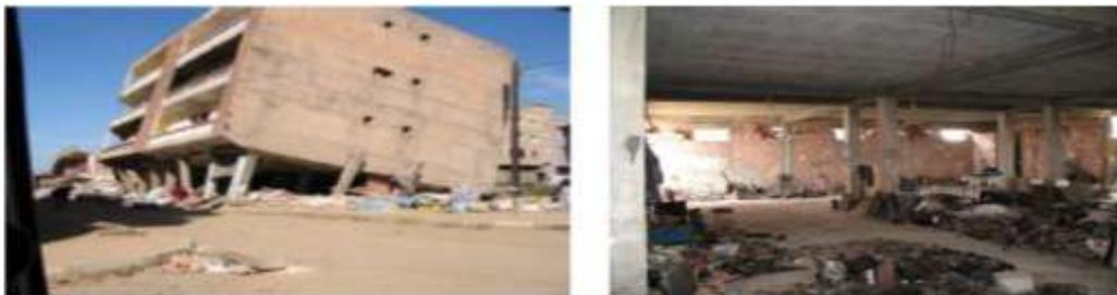
Figure II.A.15: Effondrement causé par la présence d'un étage transparent
