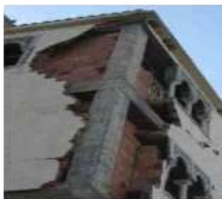
Figure II.A.16: Dommages sur les éléments non structuraux [AFPS, 2003]
