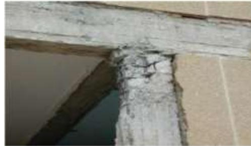
Figure II.A.8b : Rotule dans le poteau (Comportement à éviter) [AFPS, 2003]
