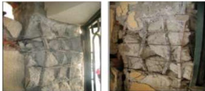
Figure II.A.10: Ecrasement du béton et flambement des aciers [AFPS, 2003]
