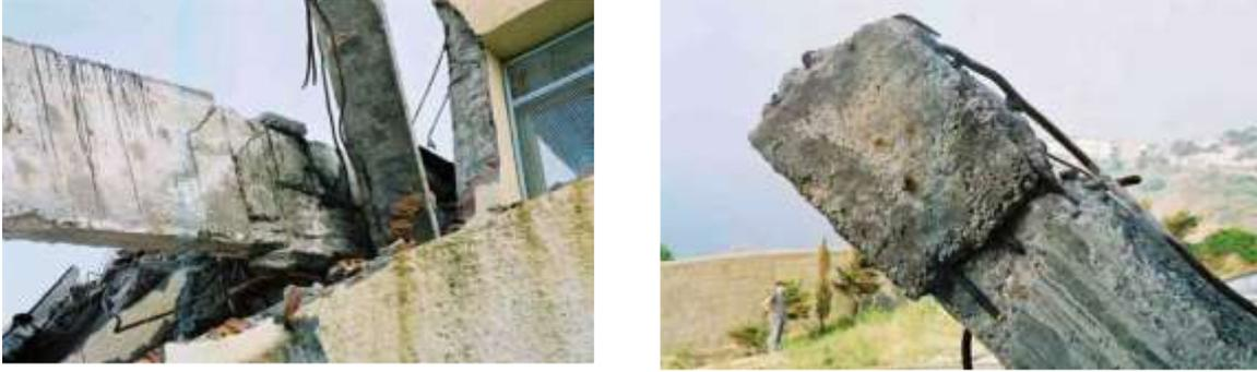
Figure II.A.17: Dommages dûs à la mauvaise qualité du béton [AFPS, 2003]
