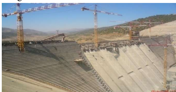
Figure I.6 : digue du barrage
