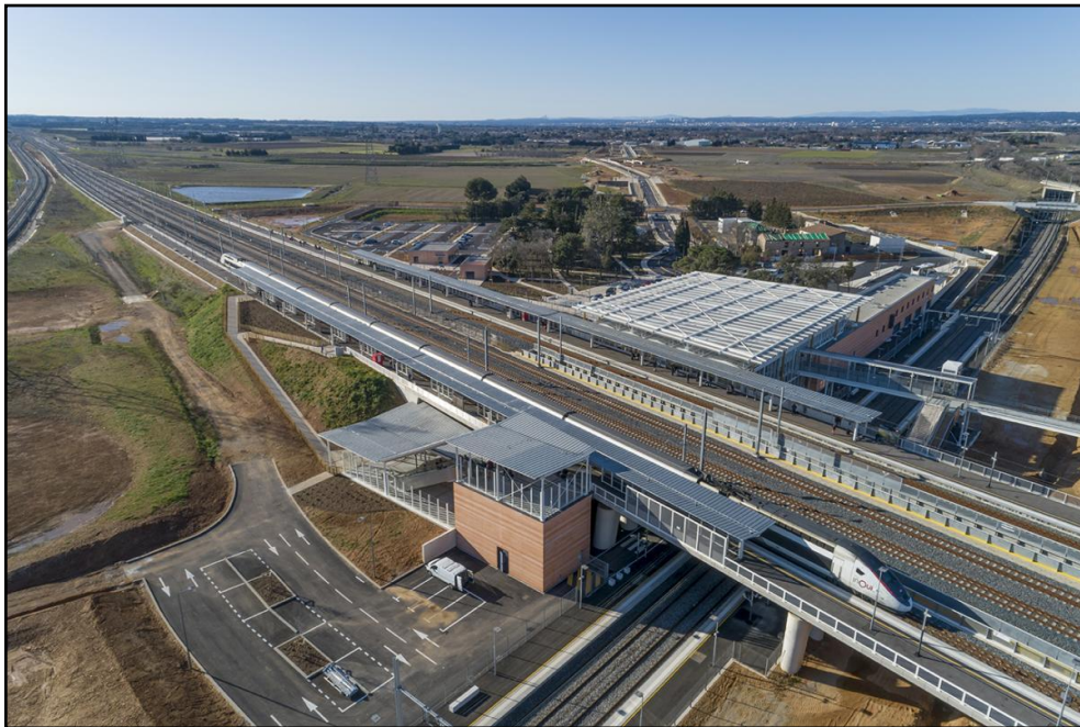
Figure II.34 : Vue sur les lignes TGV et TER Source : SNCF Gares & Connexions – AREP
