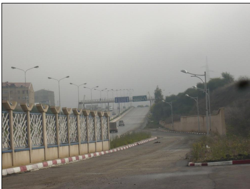
Figure III.5 : Sortie Est – Source : Auteur
