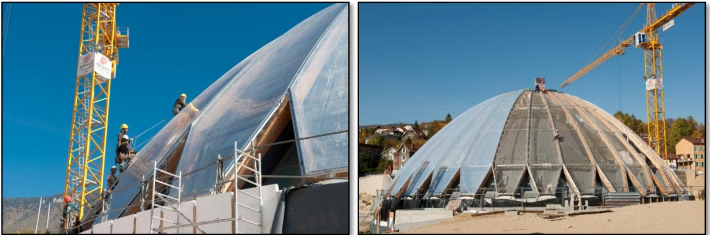
Figure II.22 :Couverture de la gare de BELLEGRADE-SUR-VALESERINE Source : www.batiactu.com
