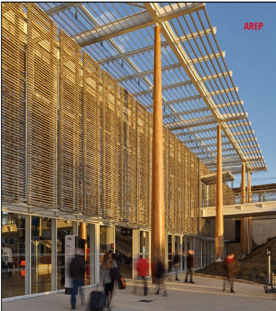
Figure II.40 : Vue sur la façade principale avec brise soleil et la toiture ombrière Source : www.spl-agate.com
