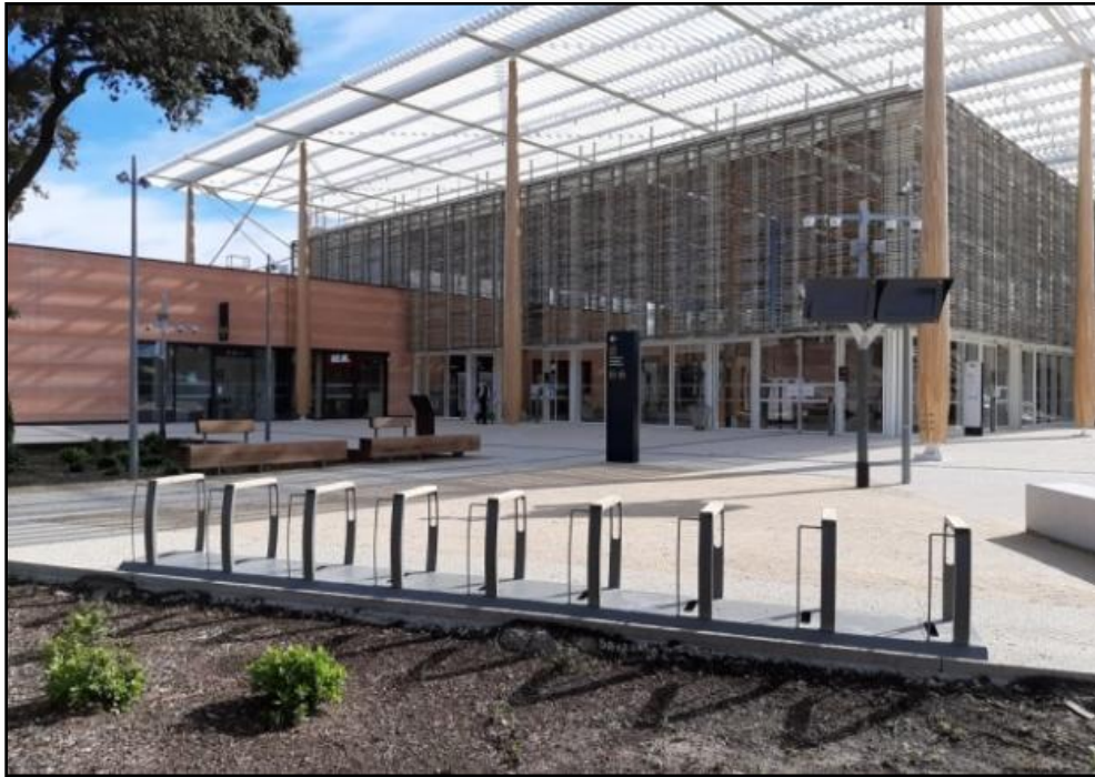
Figure II.33 : Vue sur la station de vélos - Source : SNCF Gares & Connexions – AREP
