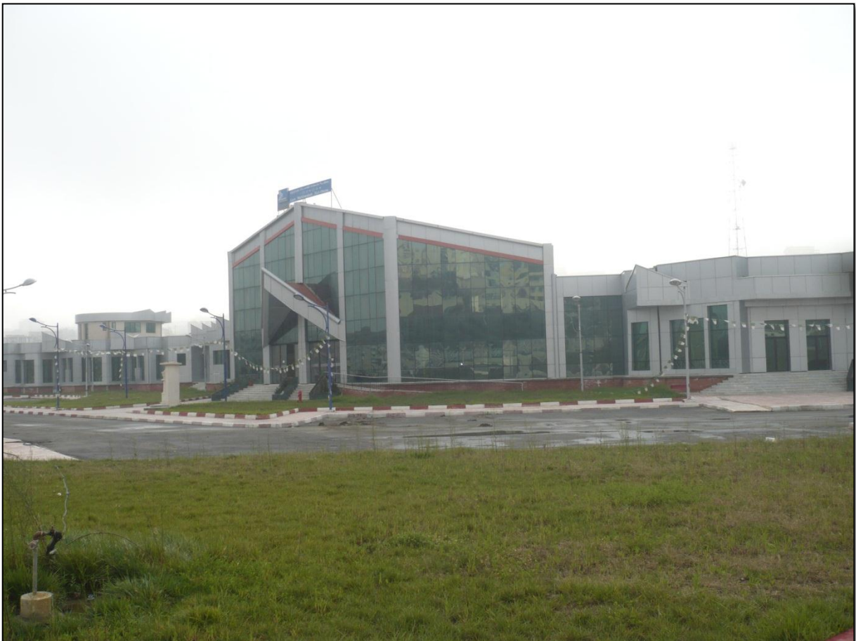
Figure III.1 :Gare multimodale de TIZI OUZOU - Source : Auteur
