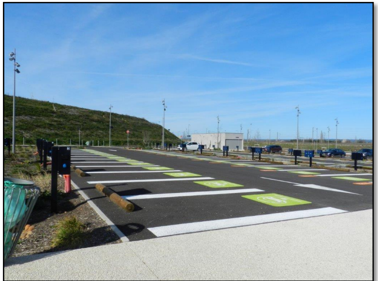
Figure II.36 :Vue sur le parking
