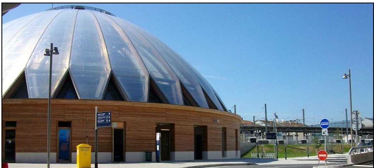
Figure II.24 : Façade de la gare de BELLEGRADE-SUR-VALESERINE Source :
