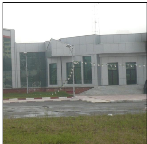
Figure III.38 : Alucobond façade Nord –source : Auteur
