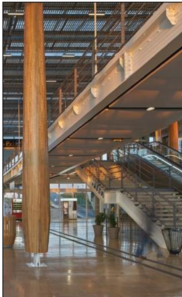
Figure II.42 Poteaux en lamellée collé Source : www.arep.fr
