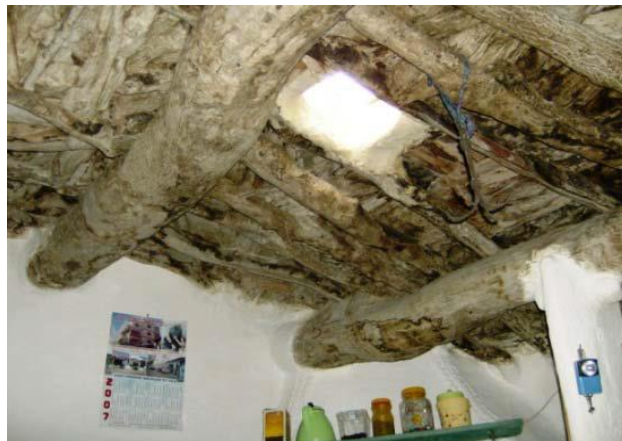
Figure 68: Ouverture sur le toit et au niveau de taârikt
