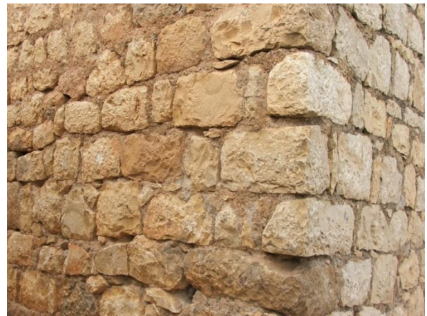
Figure 61 : un mur réalisé en pierre Source : Hossin BOUILLES
