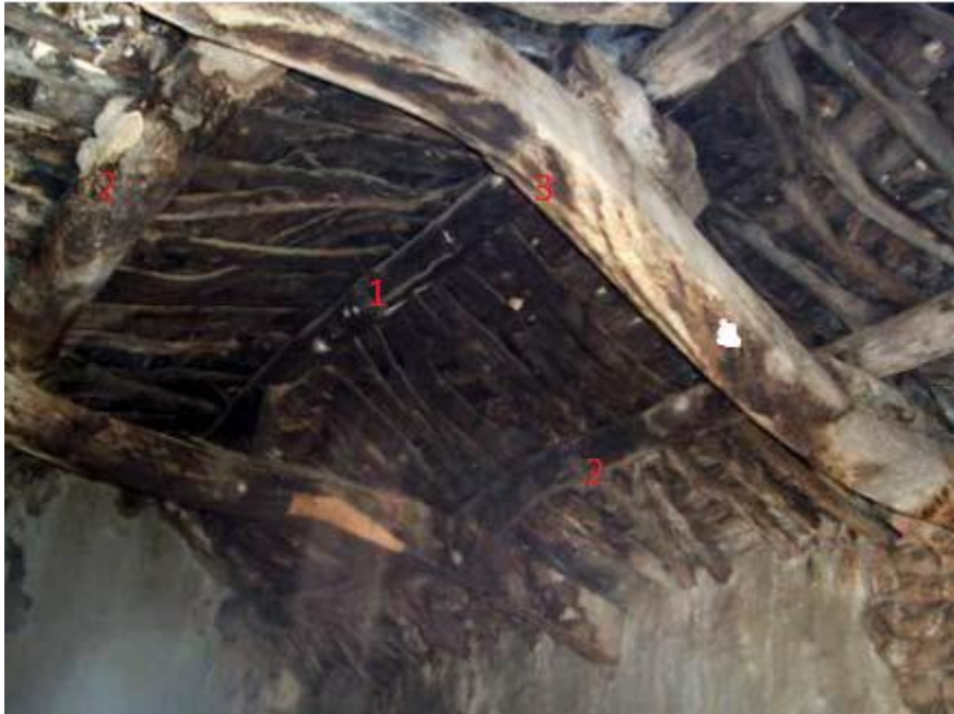
Figure 63: vue representant les poutres ; 1 : assalasAlemass ; 2 : IssoulesIdherfiyen; 3 : El Djaïza Source : les auteurs 12/12/22
