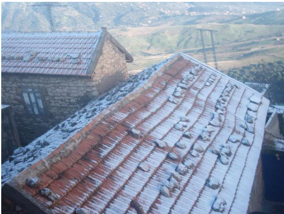
Figure 69: toiture en tuile
