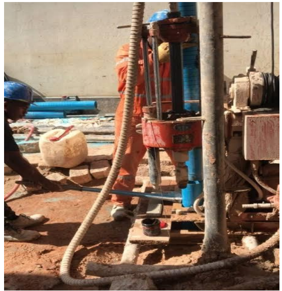
Figure 155 : forage mécanique pour les forages profonds. Source site web.
