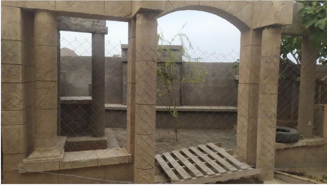
Figure 41: la stèle romaine en cours de réalisation
