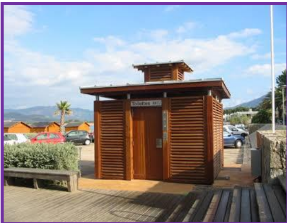
Figure 118 : toilette publique. Source : site web.
