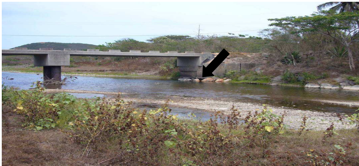
Figure 6 : Déchaussement d'un pont, début d'affouillement au niveau de la fondation de la Culée de rive droite
