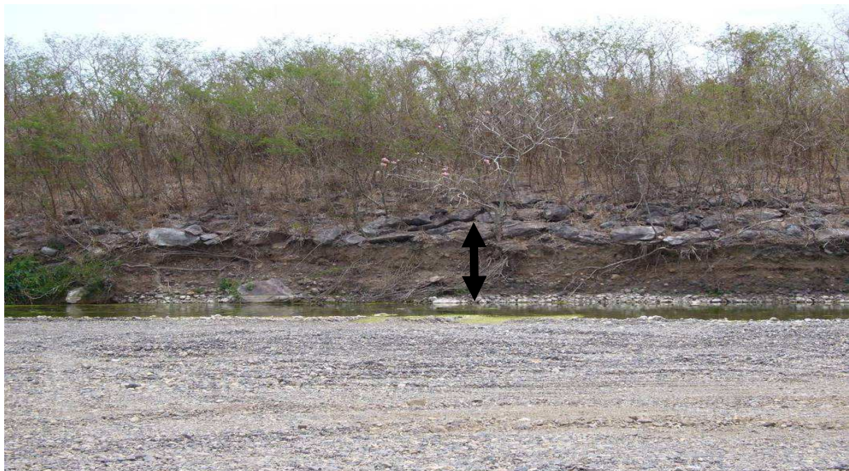
Figure 6 : Déchaussement d'un pont, début d'affouillement au niveau de la fondation de la Culée de rive droite
