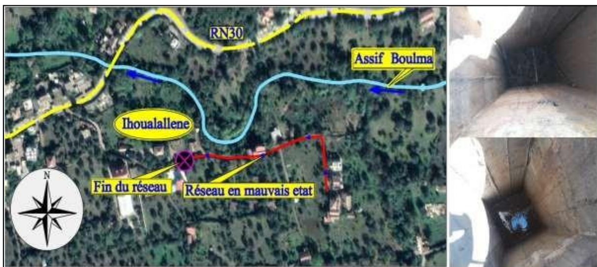
Figure II.9 : Tronçon en mauvais état.
