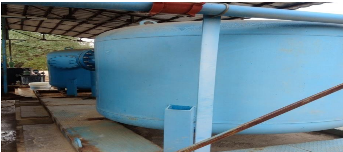
Figure n°11 : Filtres à sable fermé.
