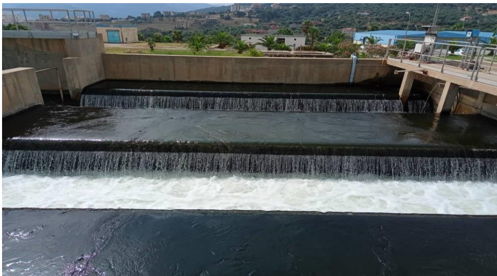
Figure n°3 : Ouvrage d'arriver de la station.
