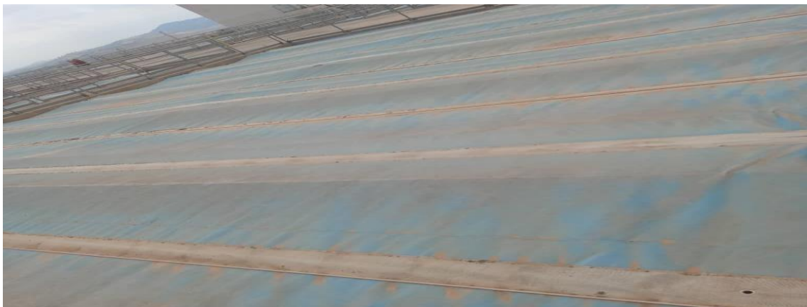
Figure n°5 : Les décanteurs de la station.
