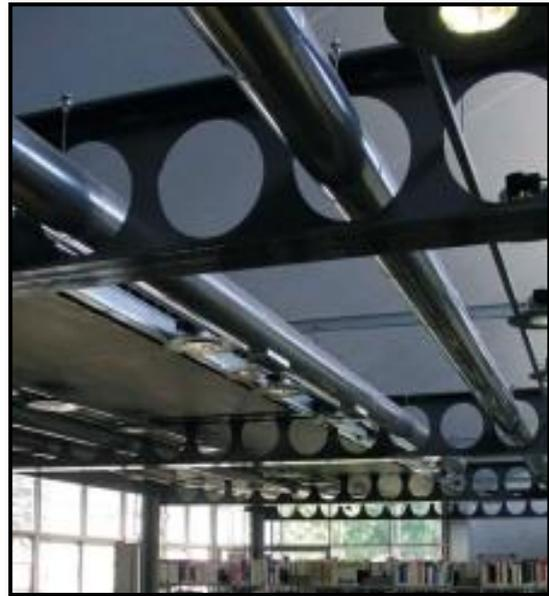
Figure 109: poutre alvéolaire
