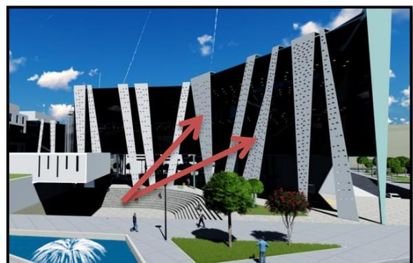
Figure 120: brise solaire en aluminium/ source: auteurs.
