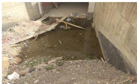
Photographie 3 : émergence de la nappe au niveau d'un chantier au niveau du musée régional à la sortie Ouest Tizi-Ouzou.
