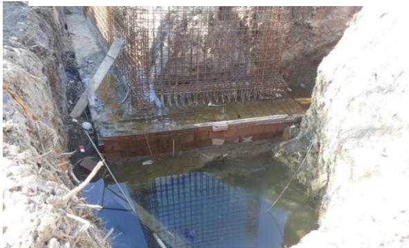
Photographie 4 : émergence de la nappe au niveau d'un chantier de la haute ville dans Tizi-Ouzou.
