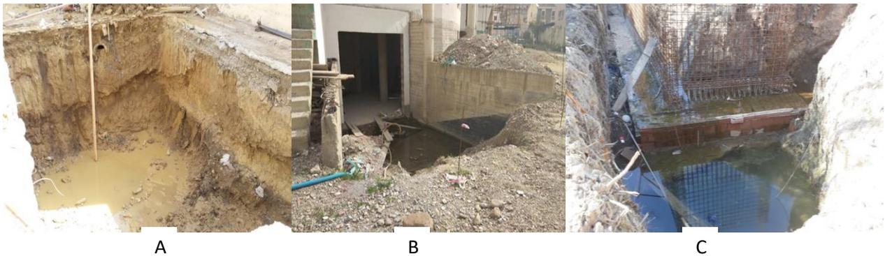
Photographies 20 : émergence de la nappe dans des chantiers respectivement à la grande rue (A) ; Boulevard Stiti et haute Ville.
