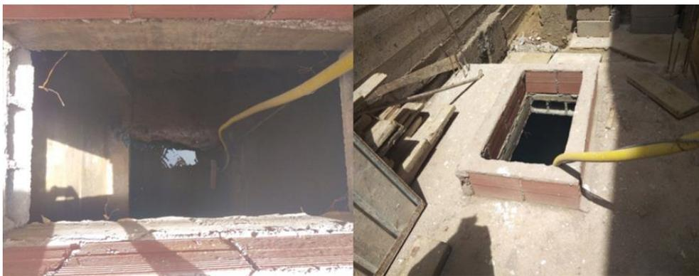
Photographie 23 : Pompage de l'eau vers le réseau d'assainissement dans un chantier à la rue de la paix.
