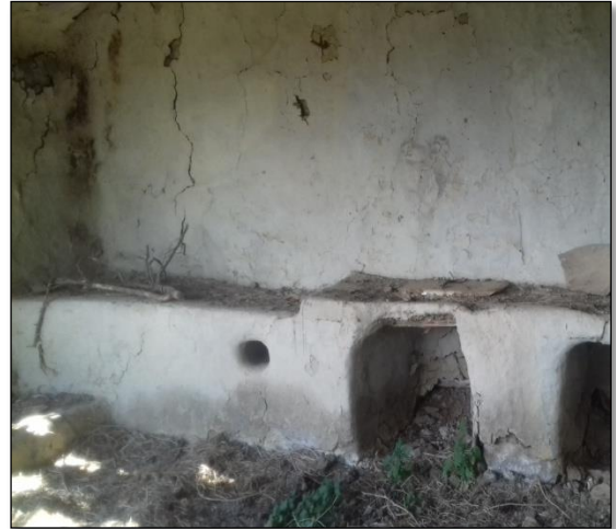
Figure104 : Revêtements intérieur. Source : Auteur 2021.
