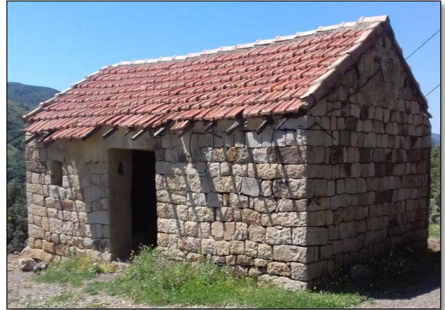
Figure52 : Couverture en tuile. Source : Auteur 2021.
