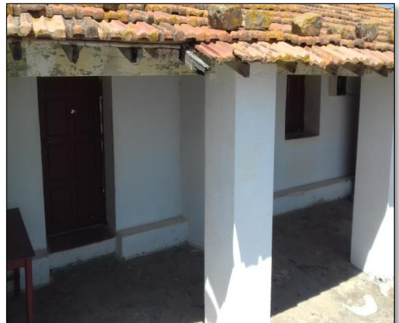
Figure94 : L'intérieur de tajmaât Mhend Outwati. Source : Auteur 2021.
