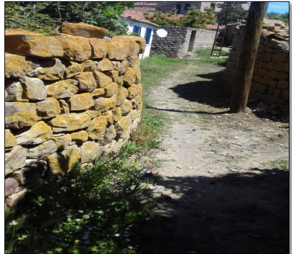
Figure88 : Ruelle de l'ancien village. Source : Auteur 2021.
