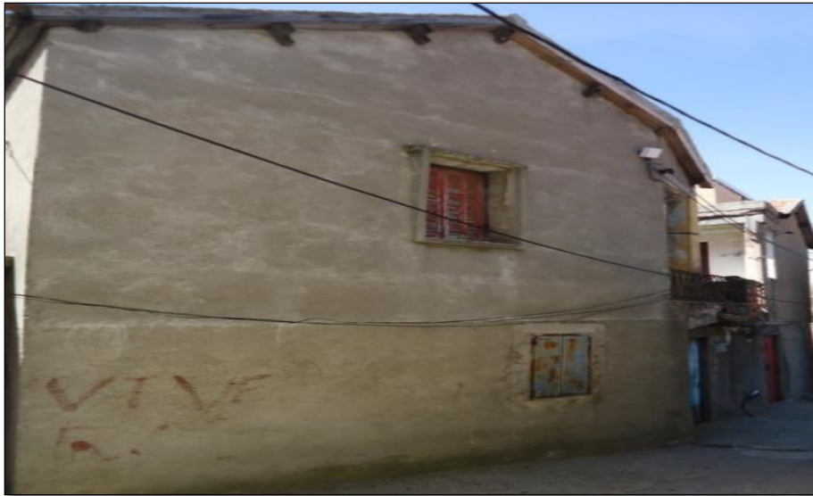
Figure56 : Démolition de l'ancien, village Berkis. Bouzeguen. Azzazga. Source : Mémoire de master Oukil et Mokraoui, 2016.
