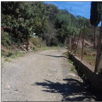
Figure82 : Voie mécanique. Source : Auteur 2021.
