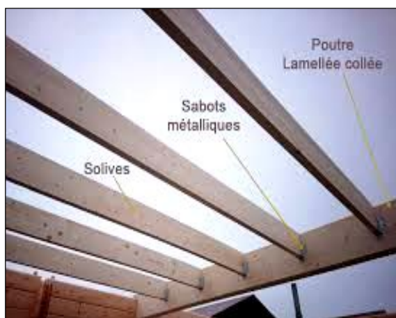
Figure170 : Assemblage poutre-solives. Source : www.boite-a-materiaux.com .
