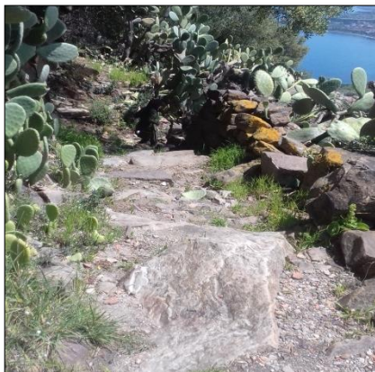
Figure85 : Voie piétonne 2. Source : Auteur 2021.
