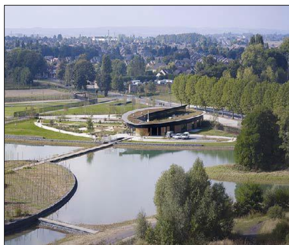
Figure120 : Maison d'environnement Aquatera. Source : www.office-et-culture.fr .
