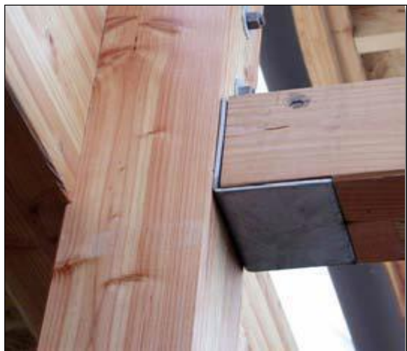
Figure168 : Assemblage poteau-traverse. Source : www.constructionbois.bilp.fr .
