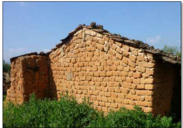
Figure50 : Maison kabyle construite par le pisé de terre. Source : www.kabylie.com .
