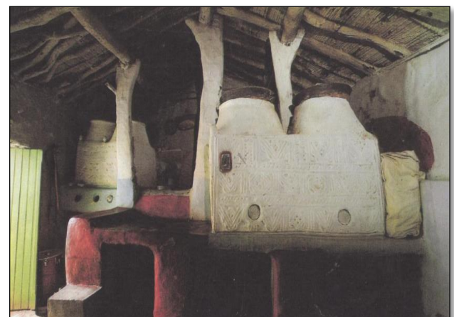
Figure51 : Les piliers en bois (superstructure). Source : www.kabylie.com .
