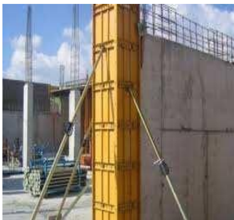
Figure1.4 : coffrage métallique et en bois
