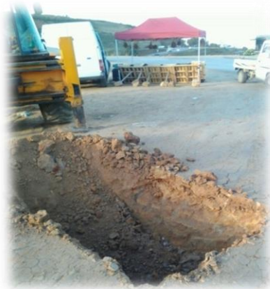
Figure 11 : Photos du puits N°01
