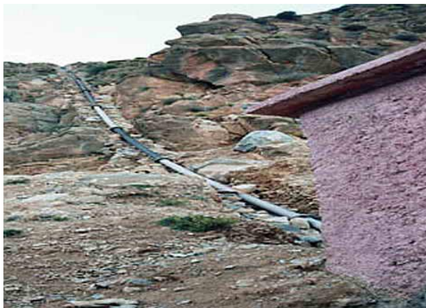
Figure. I.3 Conduite forcé et une centrale
