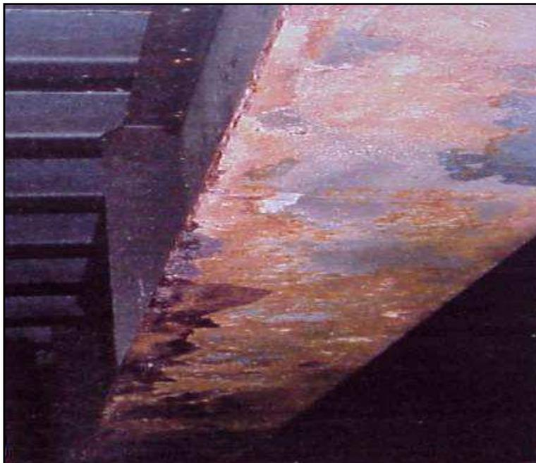
**Figure I.2** : Exemple de corrosion généralisée
