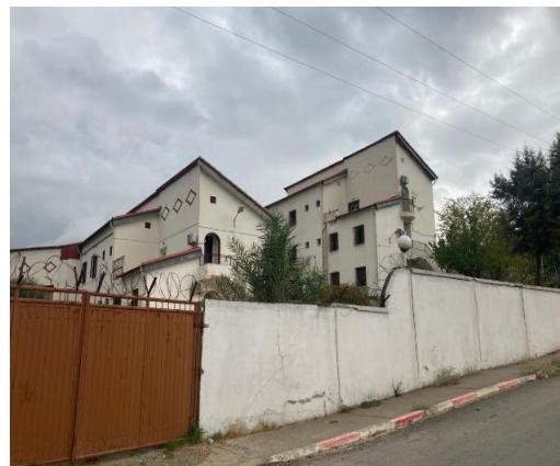
Figure 12 : Image du FPA de Boukhalfa. Source : Auteurs.
