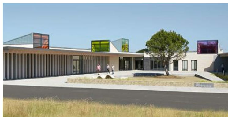
Figure 11 : Centre intergénérationnel l'Arbrasève, Rocheservière, France. Source : Plaquette-Arbraseve-gd-public-BD.
