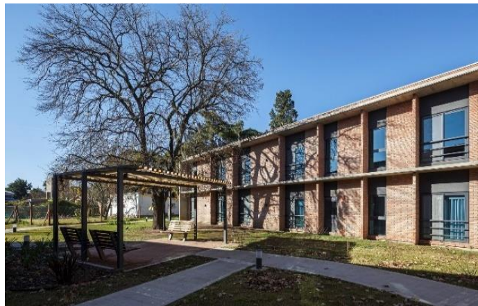
Figure 9 : Centre complet Sentidos pour personne âgées, Funes, Argentine. Source : Archdaily.
