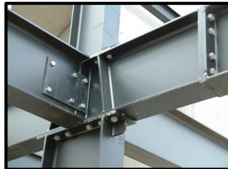
Figure 164: assemblage rigide des poutres boulonnées
