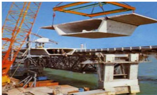
Figure VII.5 : Pont construit par encorbellement successif
