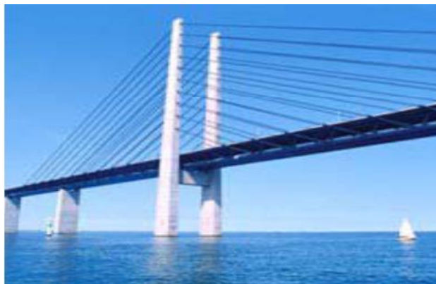
Figure VII.3 : Pont à hauban
