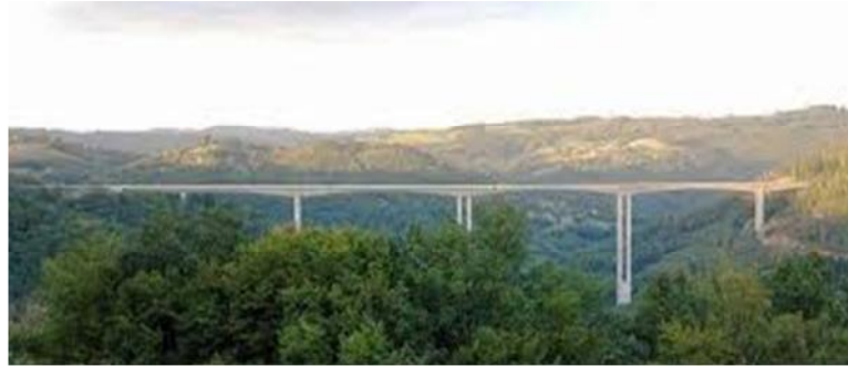
Figure VII.4 : Pont construit par encorbellement successif.
