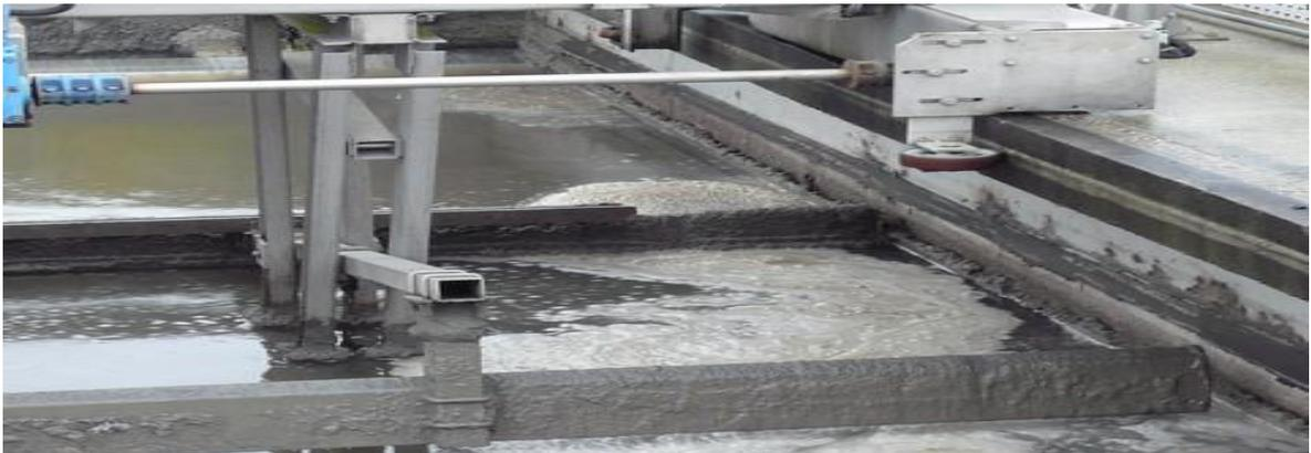
**Figure III.3 :** Déshuileur d'une station d'épuration des eaux usées.
