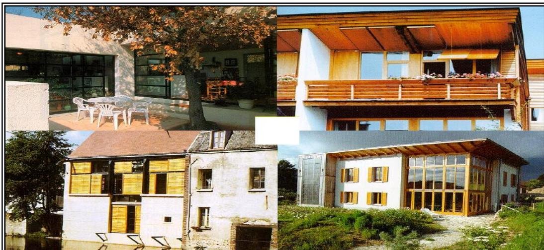
**Figure II-18** : Types de protections solaires (Source : Liebard et de Herde, 2005)
