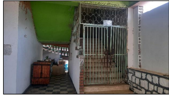
Figure 56: la circulation verticale intérieure dans le bâtiment de l'ancienne gare, source : auteurs
