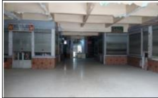
Figure 53: photo du système constructif du bâtiment de l'ancienne gare, source : auteurs
