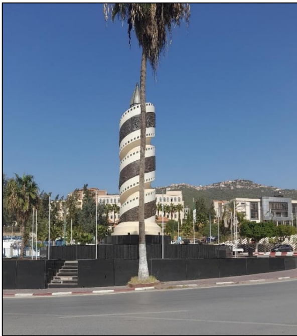
Figure 110: photo de L'intersection de la bougie avant l'intervention, source : auteurs
