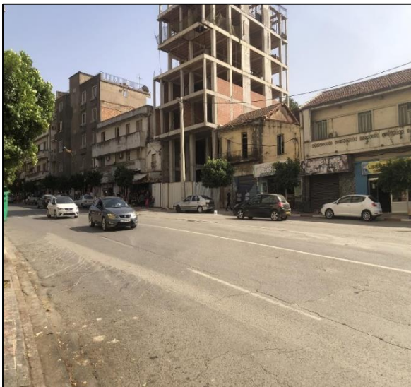
Figure 101: photo de L'avenue Larbi Ben M'hidi avant l'intervention, source : auteurs
