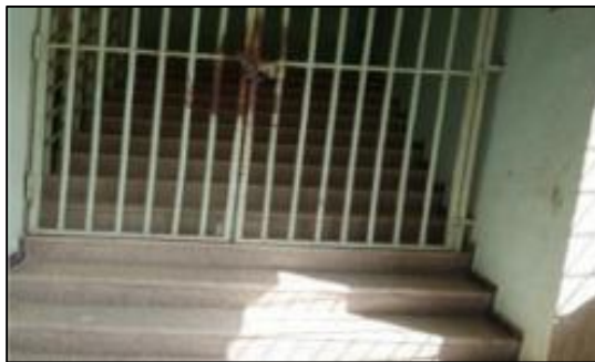
Figure 57: la circulation verticale intérieure dans le bâtiment de l'ancienne gare, source : auteurs
