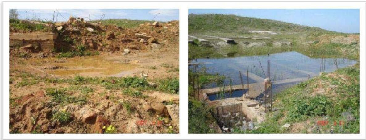
Fig II.15: Stagnation des eaux en amont dans des fondations abandonnées[15] .
