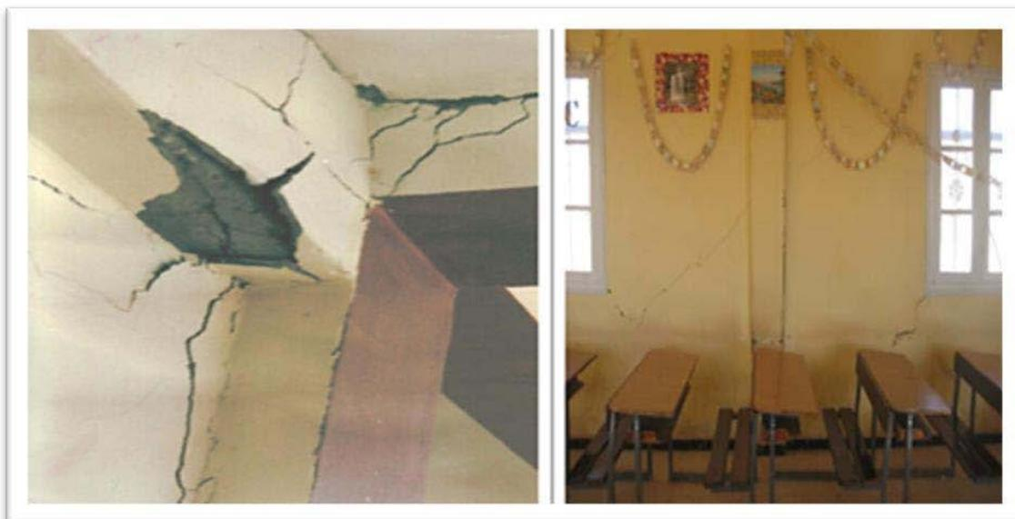
Fig II.18 : fissuration des poutres et des murs à Ain Hadjel[15] .
