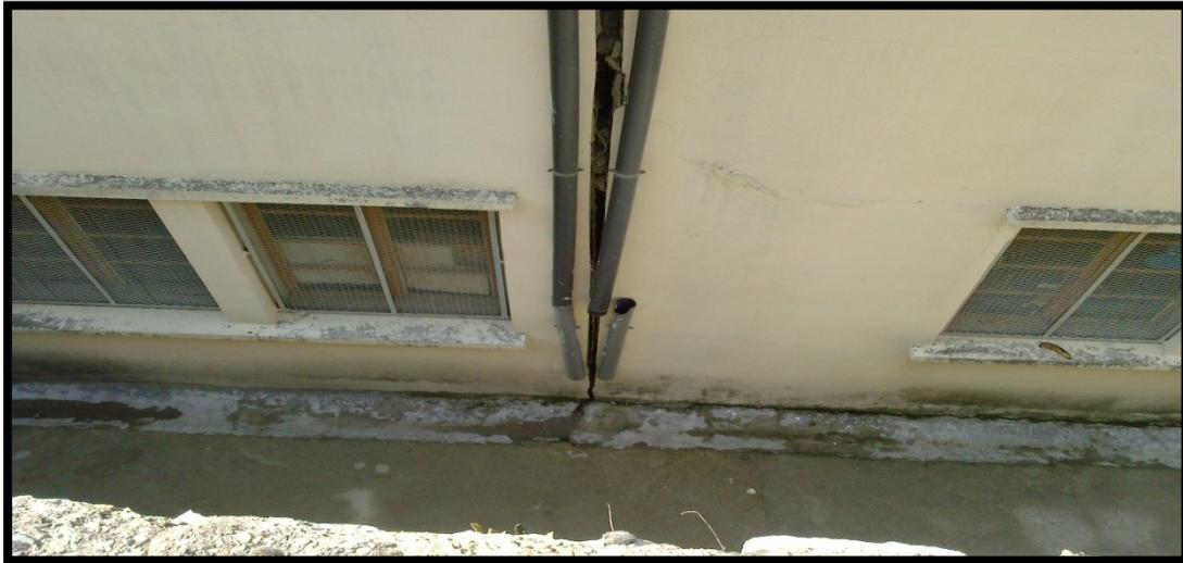
**Fig. V.13 :** Vue de l'ouverture d'un joint de dilatation de l'école des garçons d'Ain El Hammam[44].
