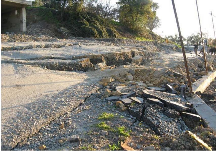
**Fig. II.22 :** Glissement de terrain à Azazga [17].
