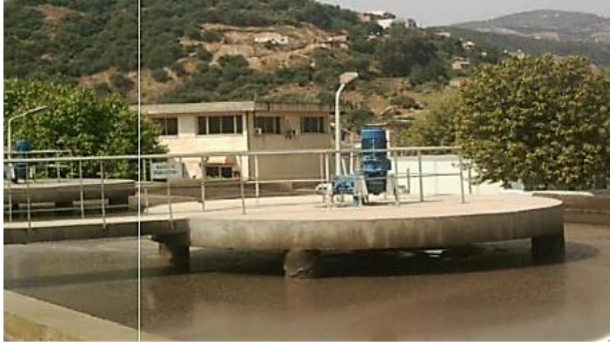
Figure 8 : Bassin de stabilisation.
