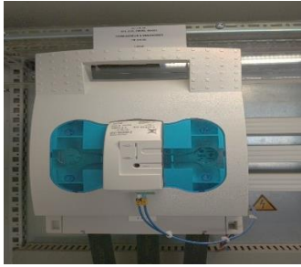
Figure II.15. Sectionneur à fusible
