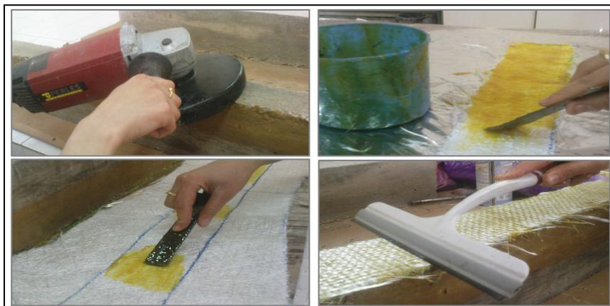
*Figure II.15. Différentes étapes pour la mise en place du tissu composite.*
