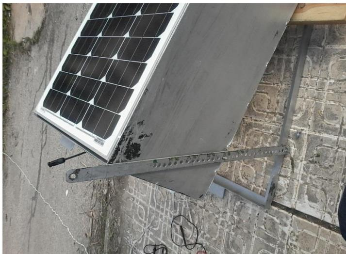
Figure III.2 : Angle d'inclinaison du panneau photovoltaïque.
