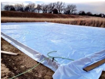
Photo 73: les étapes de création d'une patinoire extérieure (préparation du terrain) Source : https://www.rona.ca/fr/
