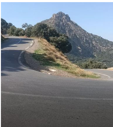
Photo 13: La RN33 Source : auteurs
