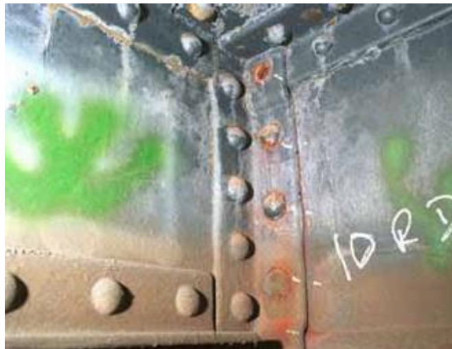
Figure IV.6 : Rivets défectueux [5]
