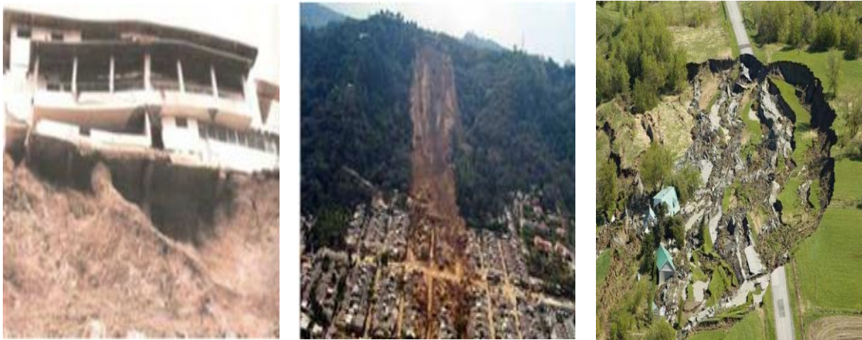
Figure I.13 : Glissement de terrain [1] [2]
