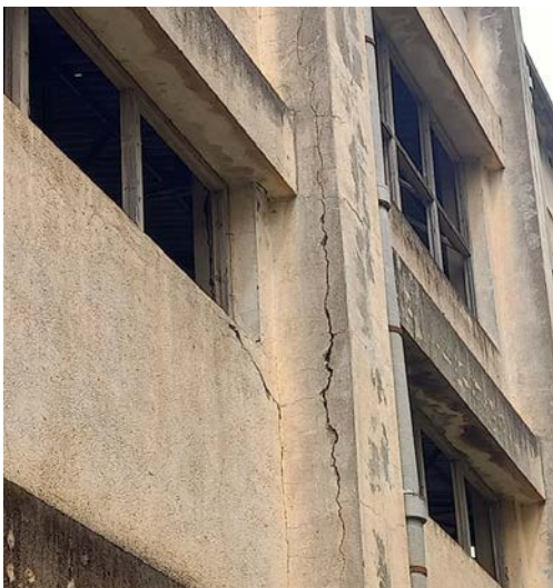
Figures VI.17a : Fissures verticales
