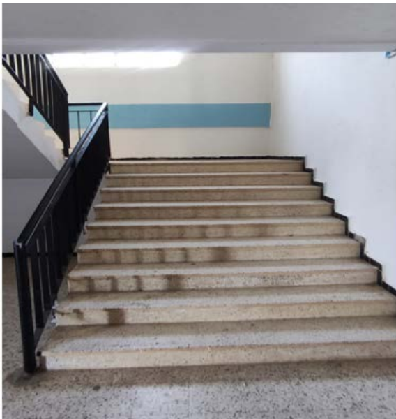
Figure VI.8a : Palier d'escalier N°01
