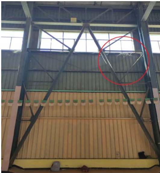
Figure VI.6a : contreventement en V inversé
