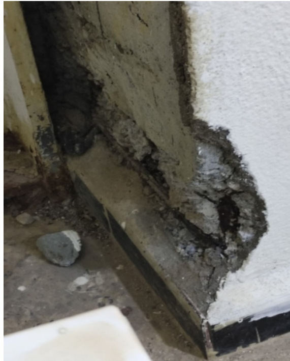
Figure VI.3 : Poteau en béton armé
