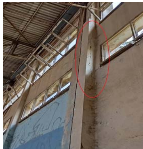
Figures VI.17a : Fissures verticales
