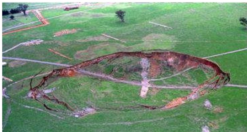
Figure I.16 : Effondrement minier survenu sur la mine d'Elura, Australie 1970 [1]
