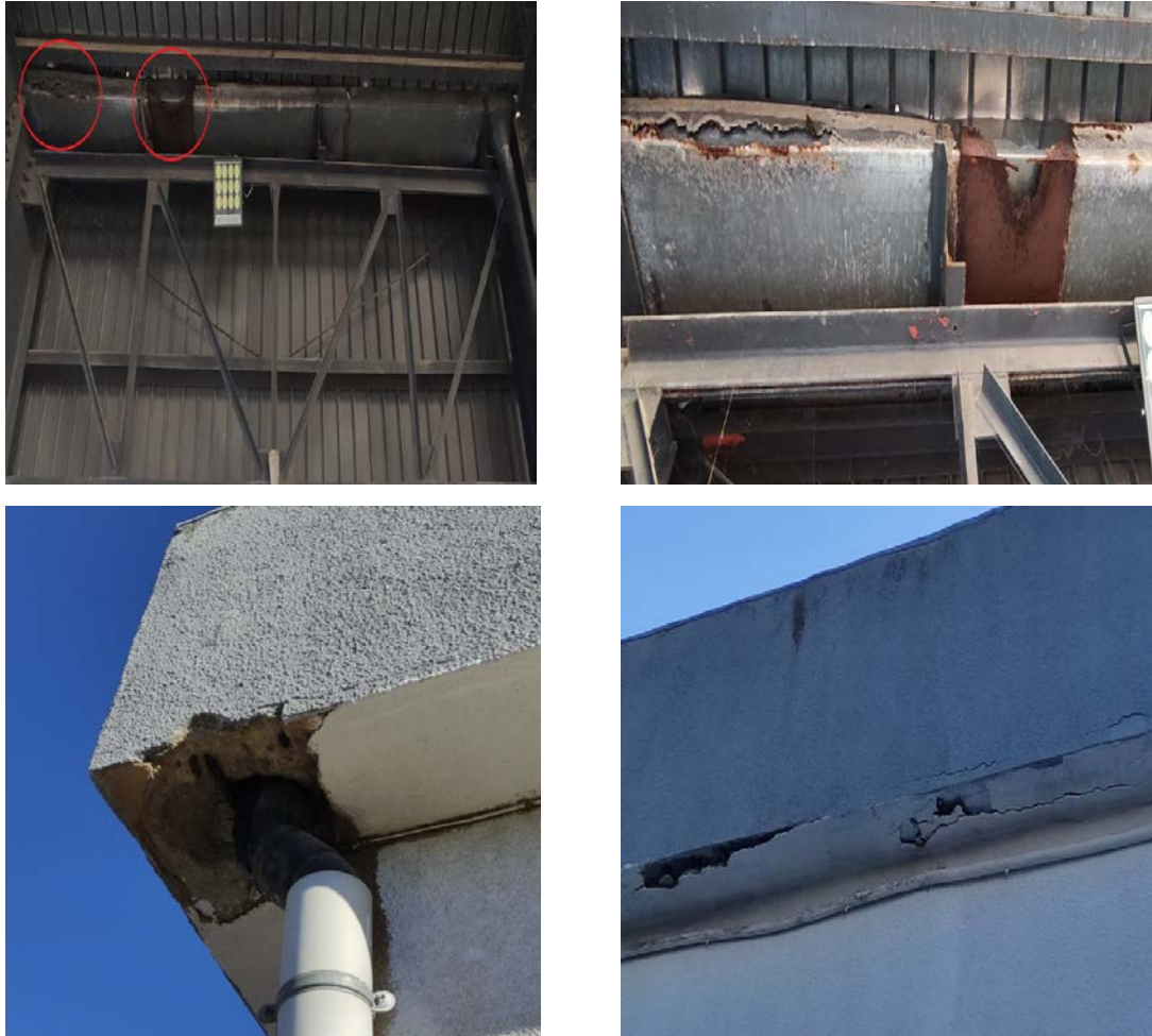
Figure VI.15 : Eléments pour évacuation des eaux
