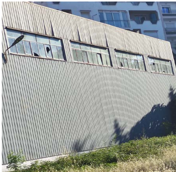
Figure VI.9 : Isolation extérieur (Panneaux sandwich)
