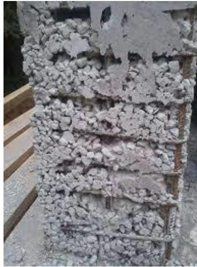
Figure I.7 : Phénomène de ségrégation [2]
