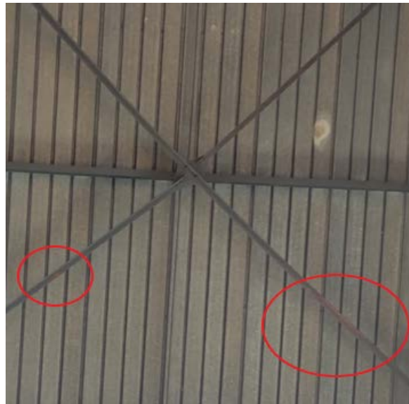
Figure VI.6b : contreventement en X
