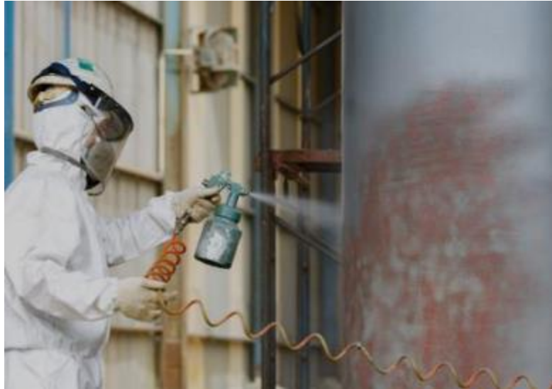
Figure IV.1 : Application d'une peinture anticorrosion [34]
