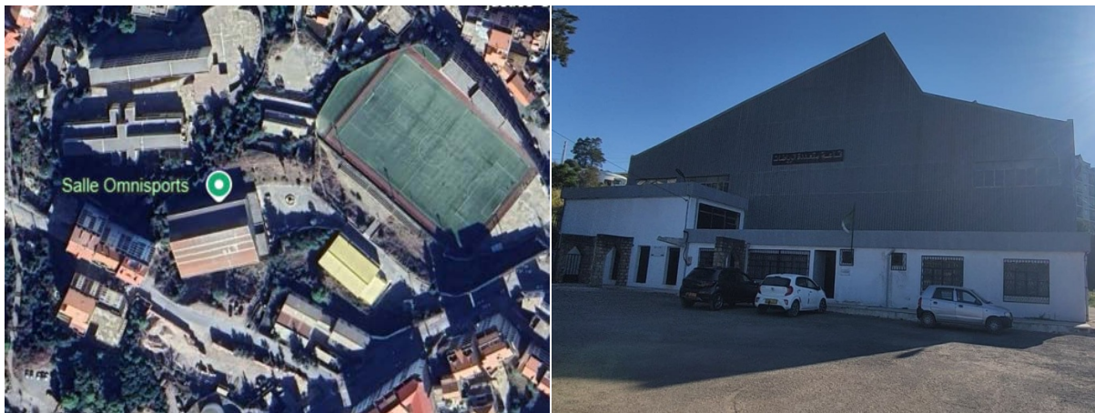
Figure VI.1 : Salle omnisport de Tizirt
