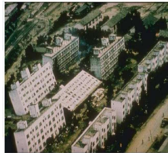
Figure I.18 : Immeubles partiellement enfouis et ayant basculé à la faveur d'une liquéfaction du sol [1]
