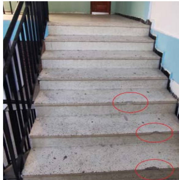
Figure VI.8b : Palier d'escalier N°02
