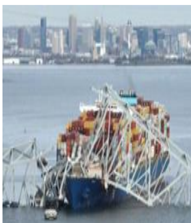
a) Choc d'un bateau sur un pont aux USA
