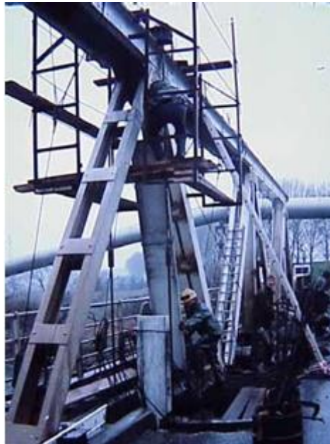
Figure IV.4 : Remplacement d'un montant d'une poutre à treillis [5]
